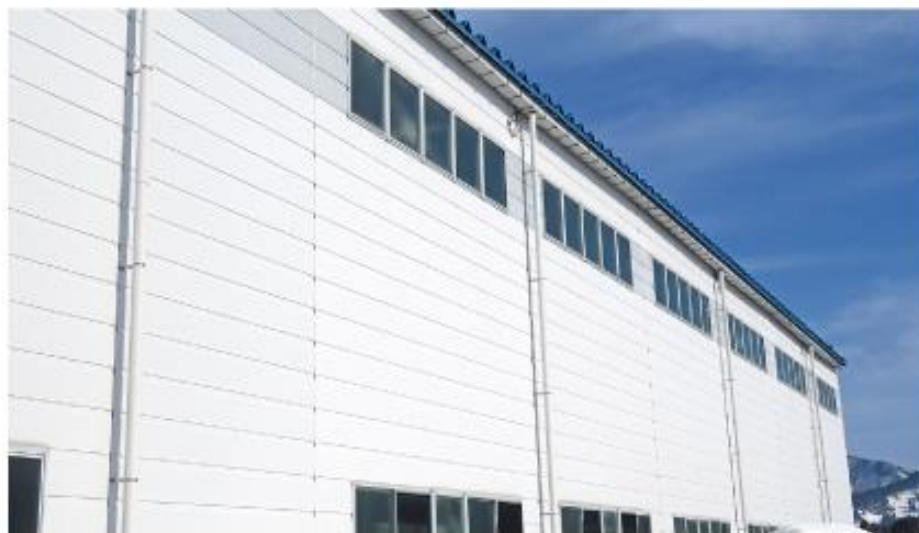
使用商品：本壁W(ポリエステル樹脂塗装品) 施工日：平成15年(2003年) 施工後19年経過した2022年に撮影 物件：アイジー工業(株)東根工場I棟
